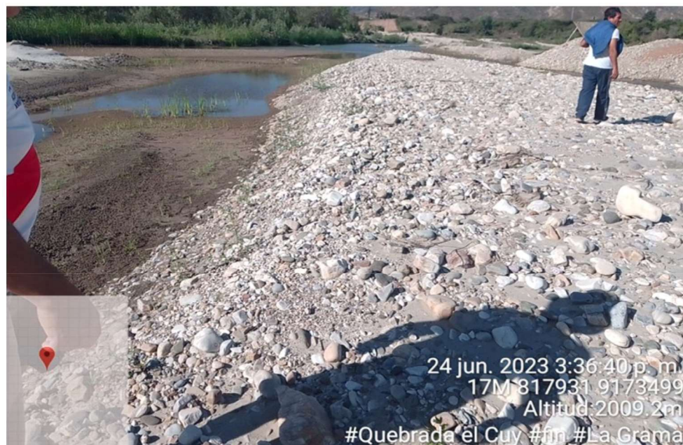
FOTO 05 : En la vista se observa el cauce arenado y con una protección rustica
